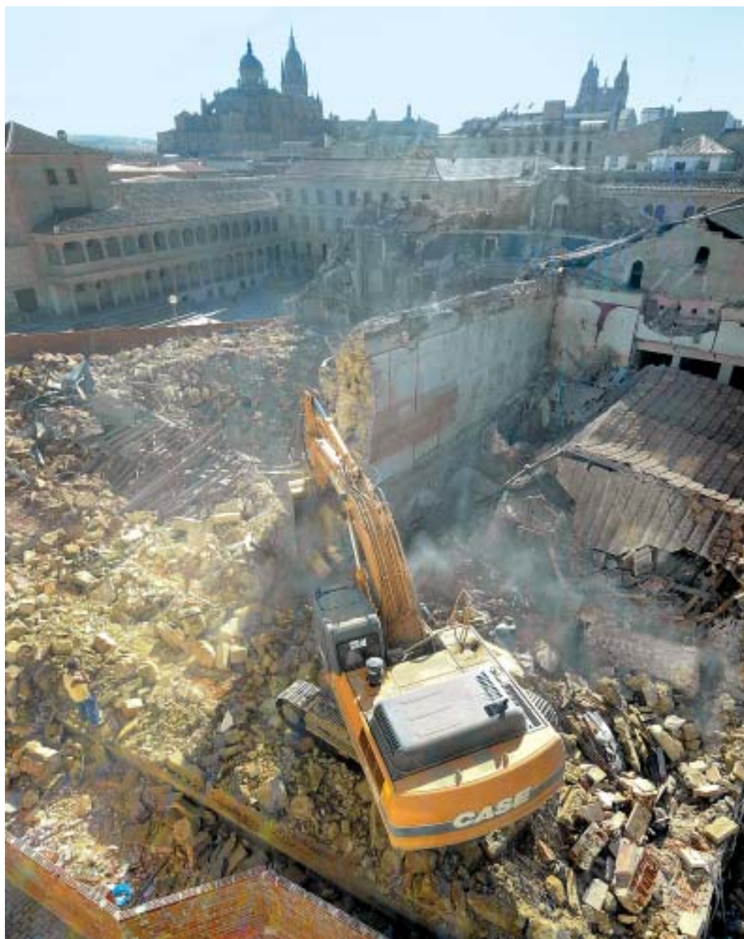
Trabajos de demolición del histórico teatro, durante la tarde de ayer./M.BARROSO
